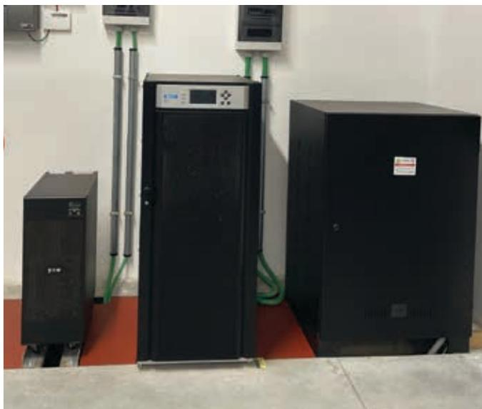
UPS serie 9E e 93E Eaton con centrale di rilevazione incendio serie CF3000 installati nella sala data center
