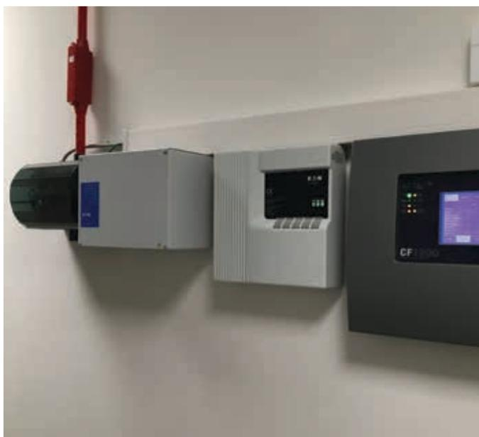
Sistema di rilevazione incendio CF1200 completo con modulo di controllo delle sirene CSC354CPR, centralina di aspirazione ILS1 e alimentatore serie SPS
