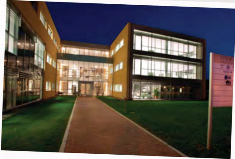
Malpensa - 2005/2011 Palazzine Uffici Avioport
