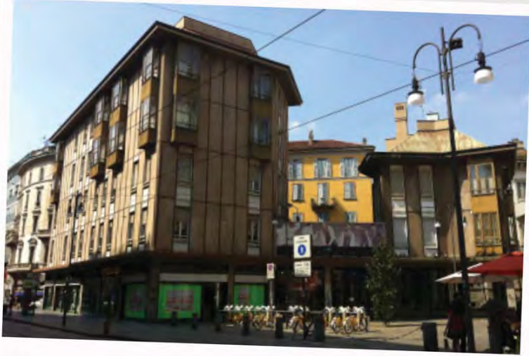
Milano - 2011 Palazzo Corso Torino
